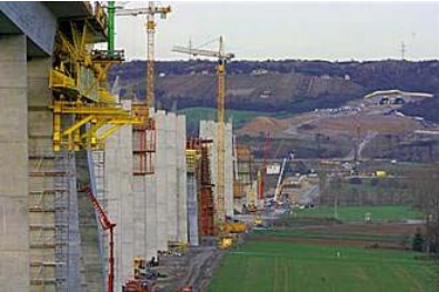
Die ICE-Neubaustrecke Erfurt – Nürnberg – Leipzig, hier die 2,7 Kilometerlange Unstruttalbrücke bei Karsdorf, ist neben Stuttgart 21 und der Hochgeschwindigkeitsstrasse nach Ulm das größte und teuerste Projekt der Deutschen Bahn. Foto: dpa
